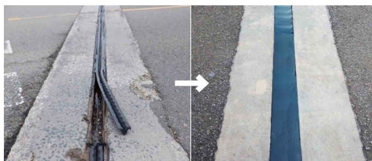
「ゴム劣化取替工法」【NETIS QS-180049-A】
